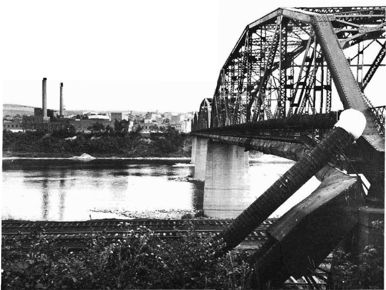
Pipeline pour le transport de la pâte d'Edmundston à Madawaska
